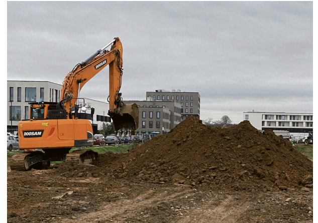
Die Arbeiten haben begonnen.
