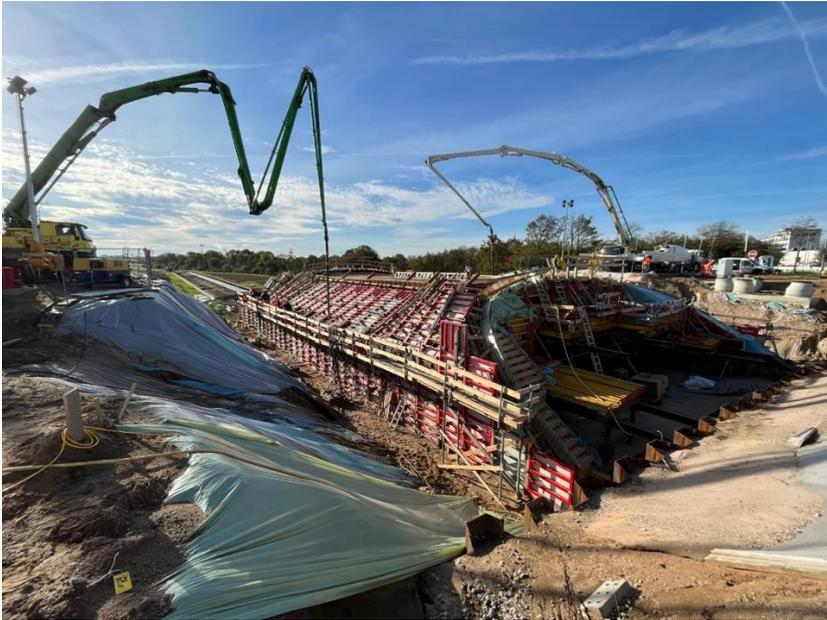
Um die speziellen trompetenförmigen Rundungen des Radschnellwegtunnels in Mannheim zu realisieren, wurde die alkus<sup>®</sup> SF Flex Schalungsplatte in 4 Millimetern Stärke für die Innenschalung (Sonderschalung) eingesetzt. | © Kiefer Schalungsbau GmbH
