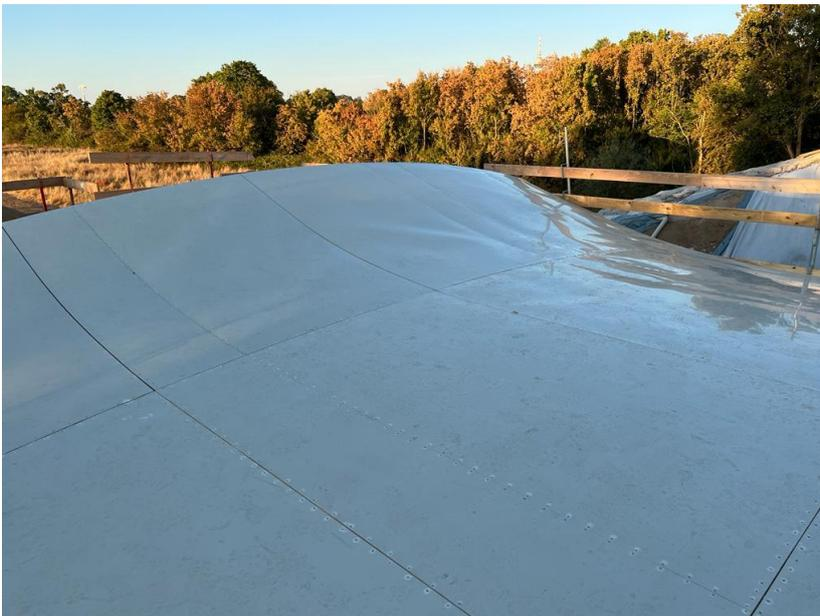
Selbst beim extremen Biegen der alkus<sup>®</sup> SF Flex entstehen keine Risse, wodurch eine glatte Betonoberfläche erreicht werden kann. | © Kiefer Schalungsbau GmbH
