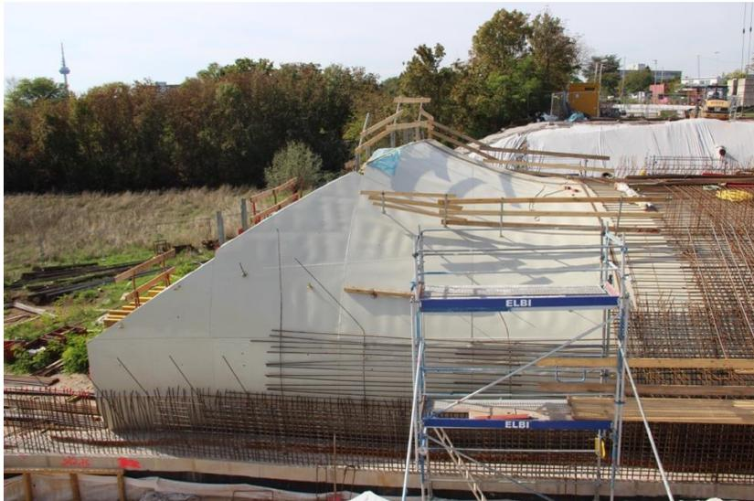
Die alkus<sup>®</sup> SF Flex im Einsatz – sie eignet sich für besonders anspruchsvolle Projekte im Sonderschalungsbau und ist in 3, 4 und 5 Millimeter Stärke erhältlich. | © Kiefer Schalungsbau GmbH
