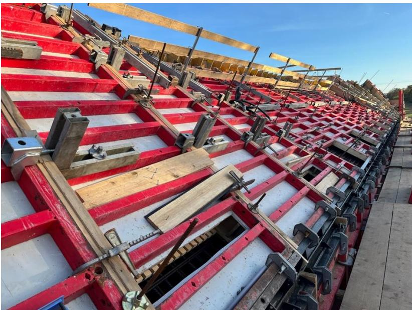
Die Außenschalung (Konterschalung) des BUGA-Tunnels wurde mit dem MEVA Mammut 350-System (Rahmenschalung) mit verbauten alkus<sup>®</sup> AL Schalungsplatten in 20 Millimeter Stärke umgesetzt. | © Kiefer Schalungsbau GmbH
