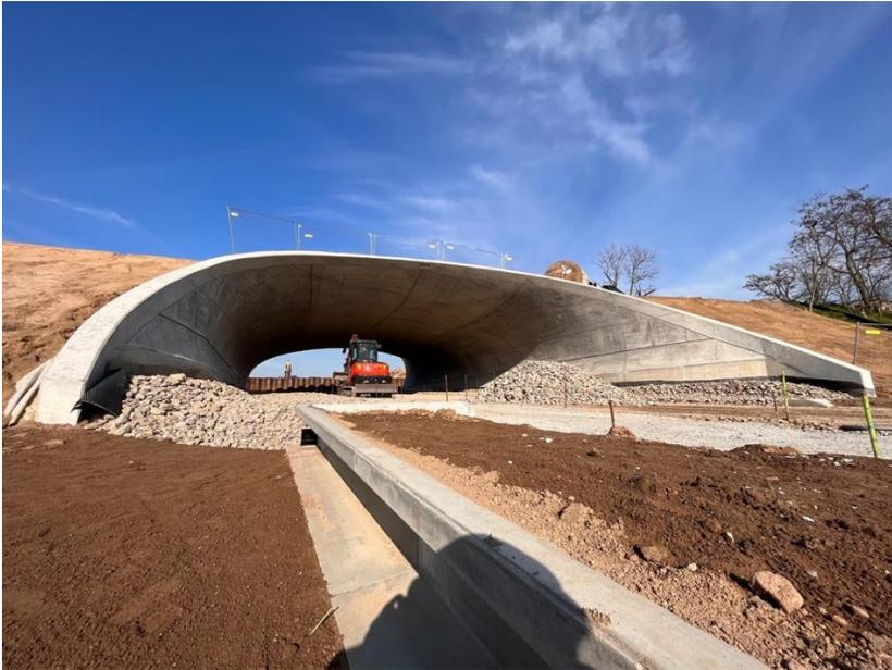
Der 40 Meter lange Tunnel über dem Schnellradweg auf dem BUGA 23-Gelände wurde in offener Bauweise realisiert. | © Kiefer Schalungsbau GmbH
